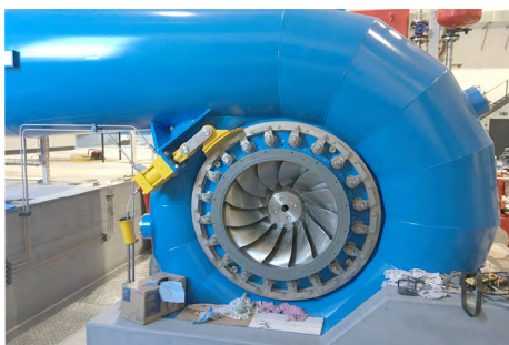
Maschine 1 mit eingebautem Laufrad
