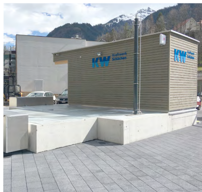
Wasserfassung Kraftwerk Schächen
