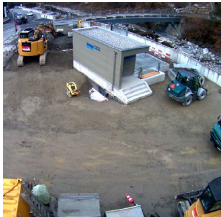
Wasserfassung Kraftwerk Schächen
