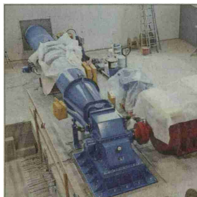
Die kleinste der drei Turbinen ist bereits installiert.
