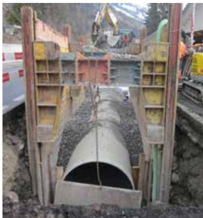
Bau Druckleitung in der Klausenstrasse
